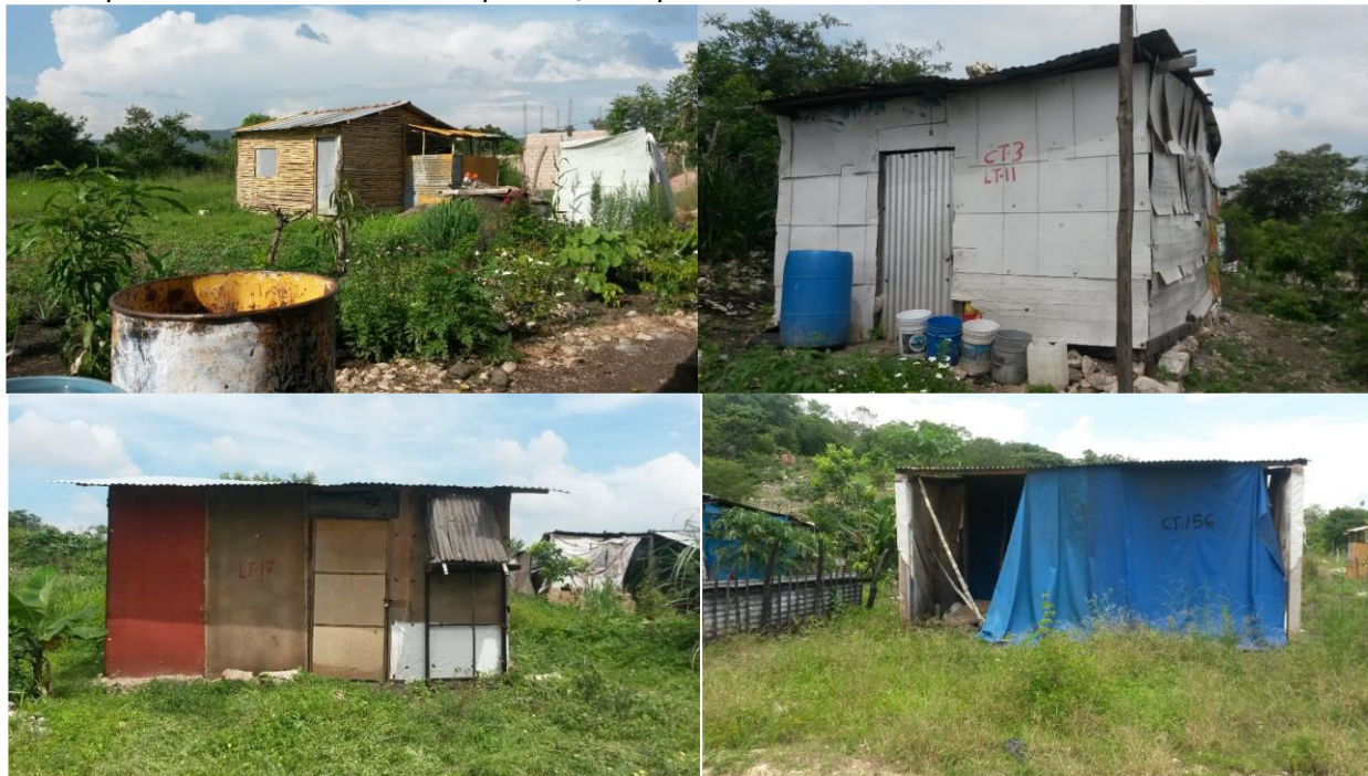
Figura 1.2.- Tipología de vivienda precaria y materiales en muros y techos, en la Colonia LCB, Municipio de Ocozocoautla de Espinosa, Chiapas.
